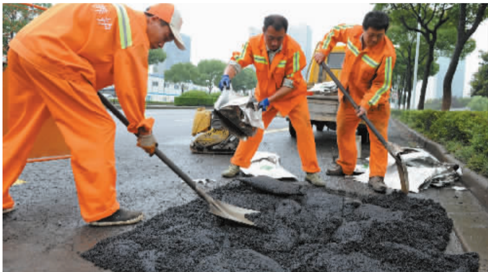
昨天,鄞州区市政工作人员在鄞县大道中段用防水沥青修补道路。
