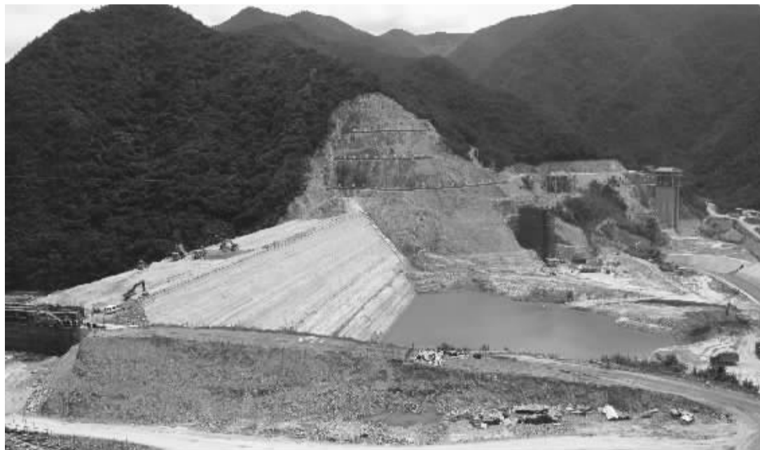
钦寸水库大坝主体工程将于9月底完工,输水洞年内全线贯通。图为施工现场。记者 边城雨 摄
