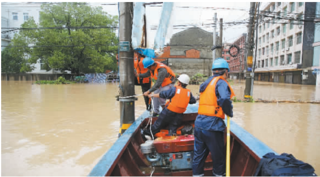
8月9日,在遭受水灾的浙江温州平阳县,供电公司抢修人员乘冲锋舟赶赴现场,恢复居民用电。
