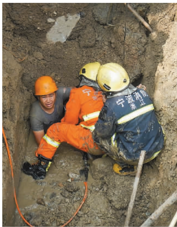
无法使用机械，消防队员只能用手刨。姚北消防中队供图
