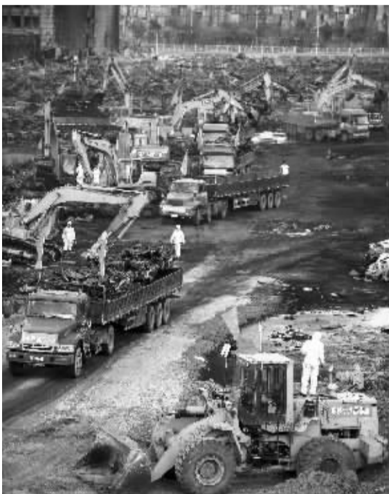
▶21日,10余辆挖掘机在清理现场。 新华社发
