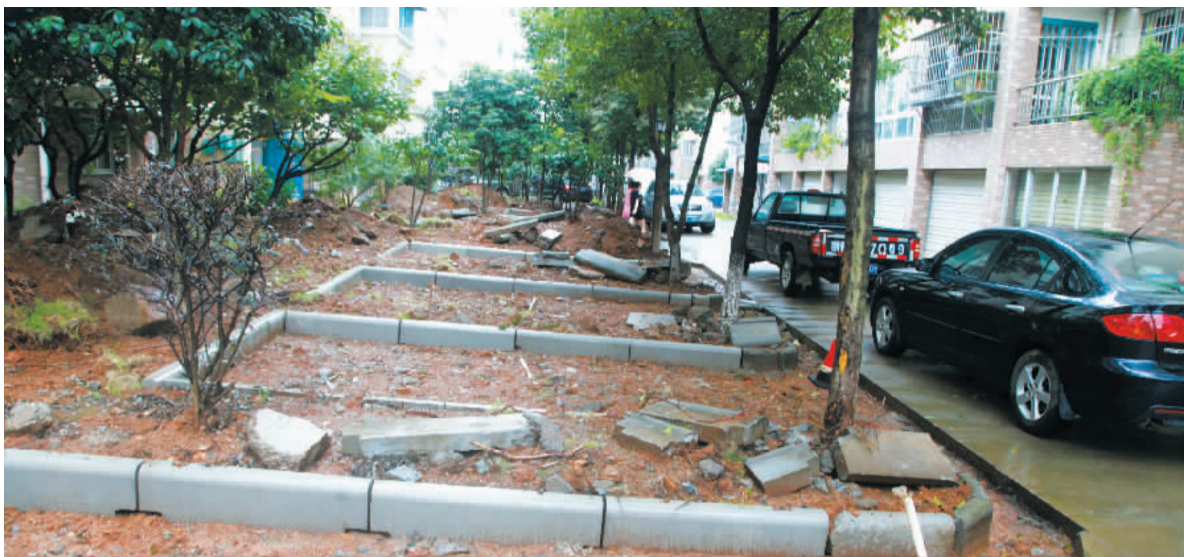
绿化带被开挖改造成停车位。 记者 许天长 摄
