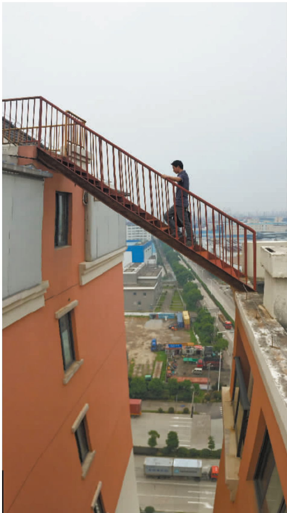
北仑京华茗苑小区两幢高楼之间架起一部简易梯子。 记者 许天长 摄
