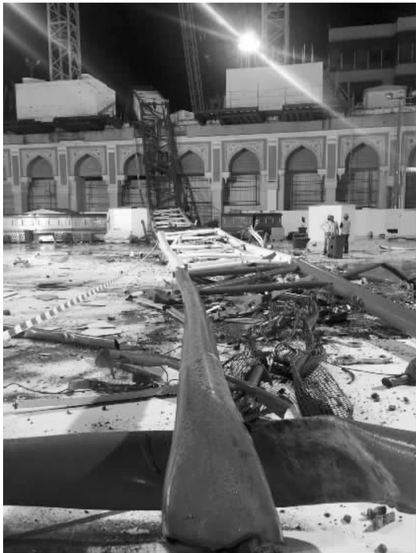
9月11日,救援人员在塔吊倒塌事故现场工作。
