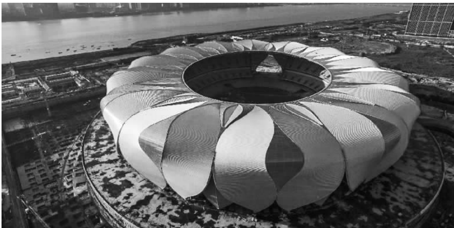
9月16日,空中俯瞰正在建设中的杭州奥体中心主体育场。 新华社记者 徐昱 摄
