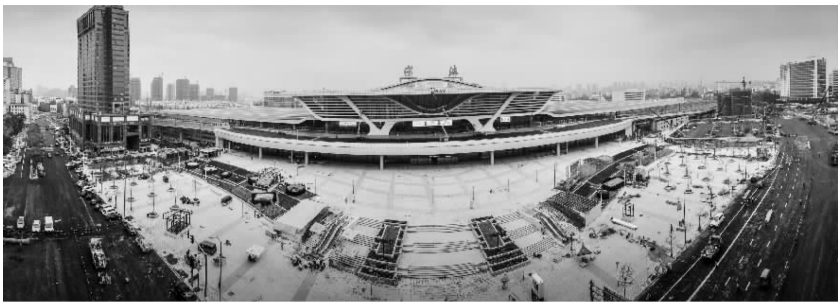
昨天下午,施工扫尾阶段的铁路宁波站北广场。 记者 徐佳伟 摄
