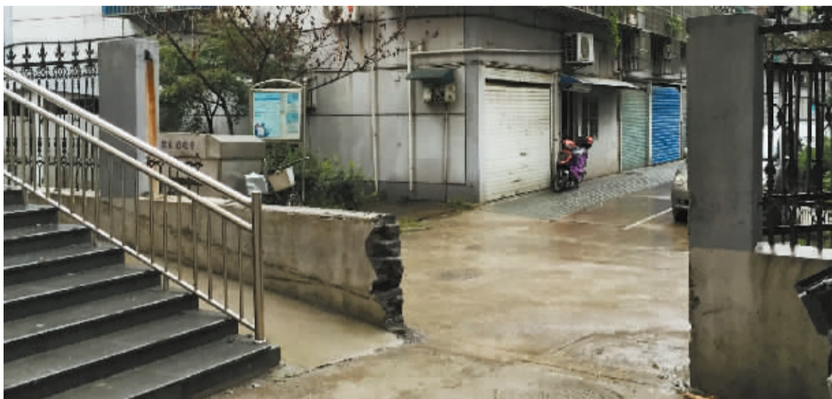
就是为这扇门,两个小区居民闹起了矛盾。 记者 唐严 摄
