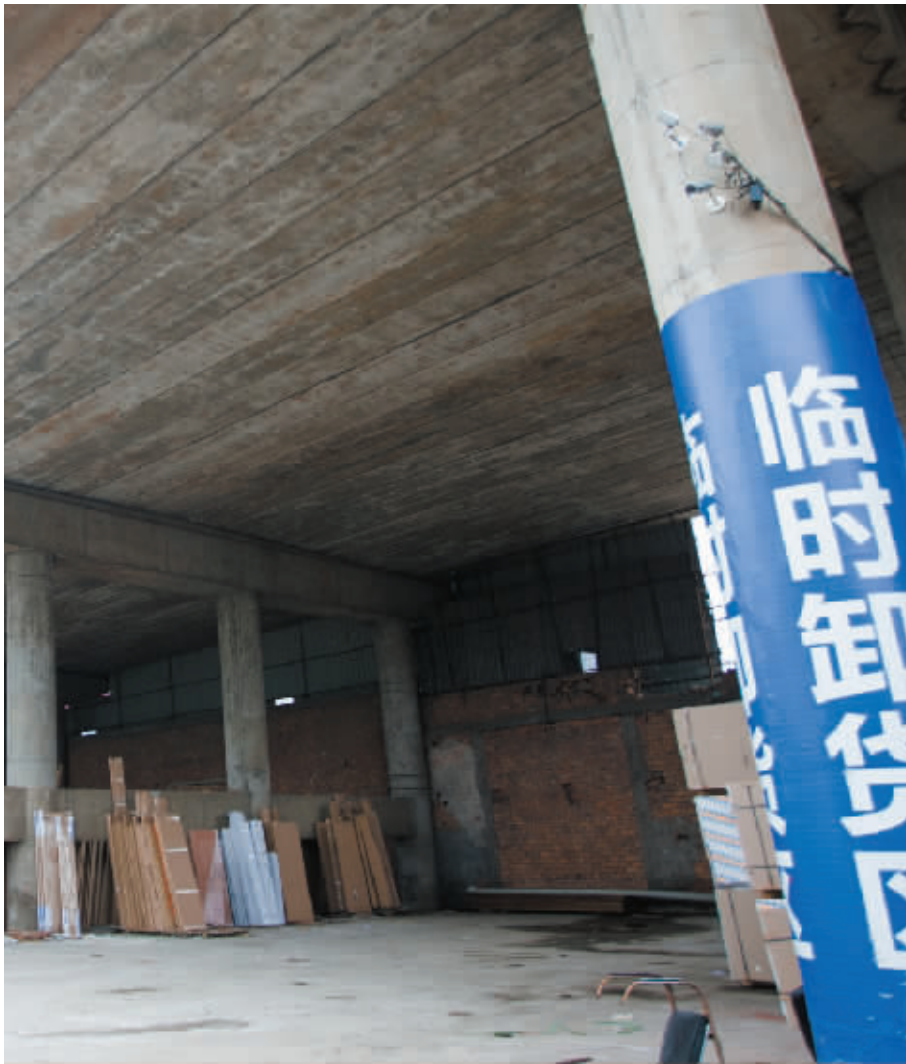
中兴立交桥下,部分区域改成了卸货区。
