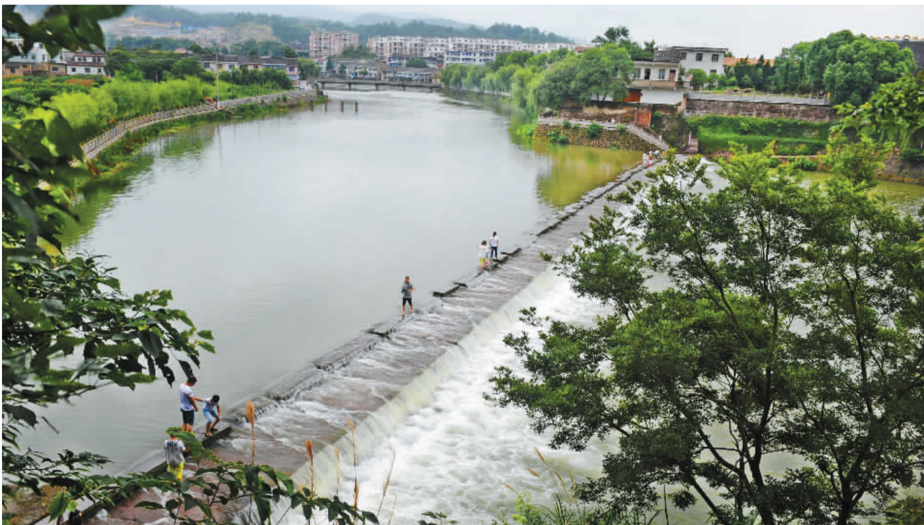
历经千年,它山堰还在继续发挥阻咸、蓄淡、引水、泄洪的作用。图为今年7月10日,受第9号台风“灿鸿”影响,宁波出现暴雨,来自上游的大水漫过它山堰的拦河溢流坝,流入下游,最后经奉化江、甬江入海。 记者 龚国荣 摄
