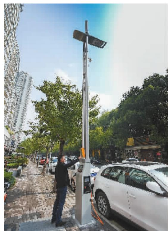
近日,一种新型的“智能路灯杆”在上海街头亮相。这种路灯杆除具备传统的照明功能外,还可以用做电动汽车充电桩、监测PM2.5的环境设备、实现WiFi覆盖的城市微基站、传达信息的信息查询系统等。新华社发
