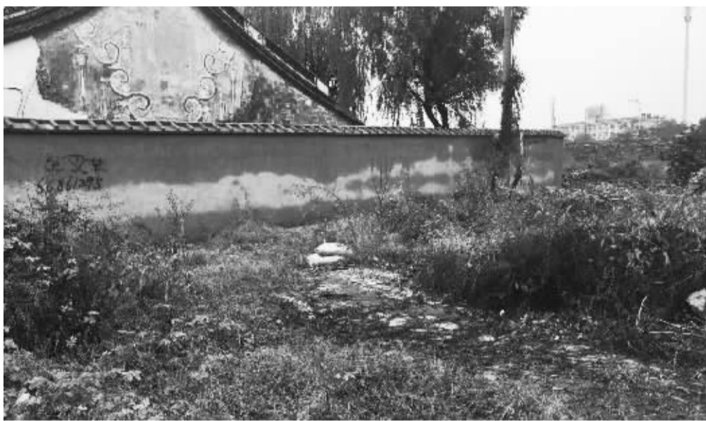
西鹭林庙墙外的荒草与垃圾。 记者 边城雨 摄
