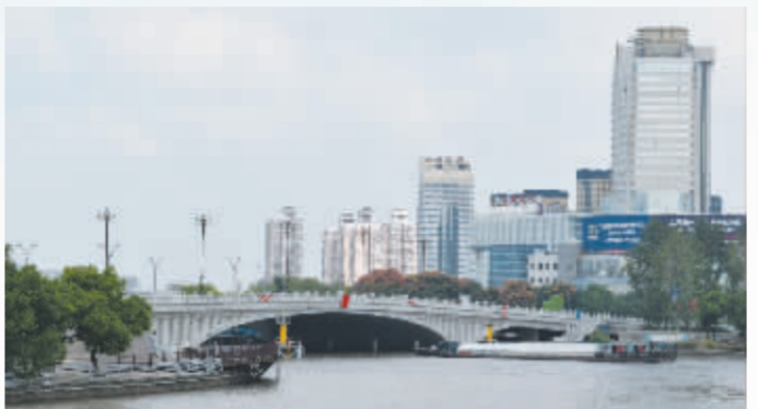
全线开通的新江桥侧影。
