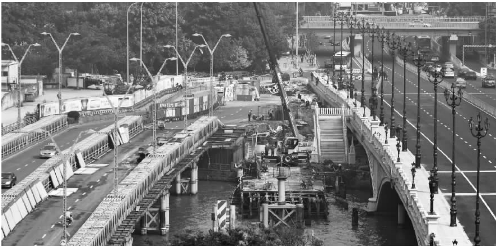
新江桥昨日全线通车,便桥也进入拆除阶段。 记者 龚国荣 摄
