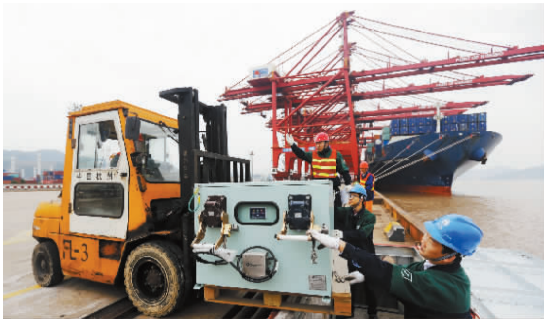
图为工作人员将岸电箱装入地井坑中。
