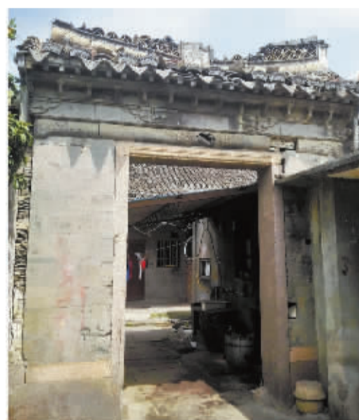
庄桥街道马径村马径茂昌房。(资料图片)
