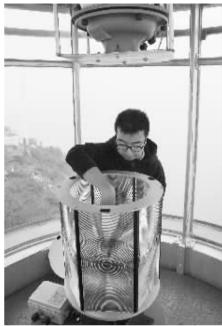
叶超群在七里屿灯塔检查灯光发射装置。 记者 唐严 摄
