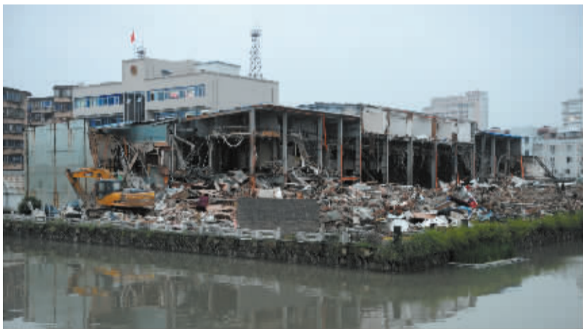
昨天下午,位于江东中兴路旁的违章建筑“英皇娱乐会所”开始拆除。
