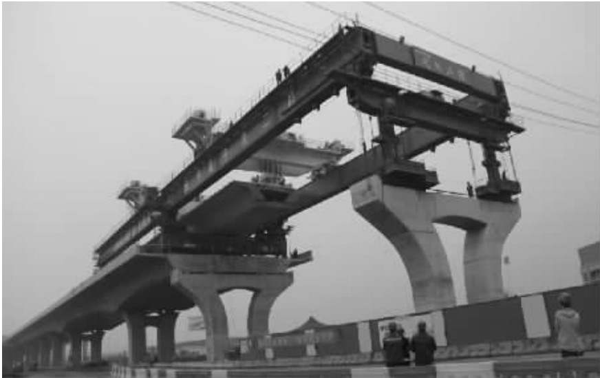
架桥机正在进行首片箱梁架设。
