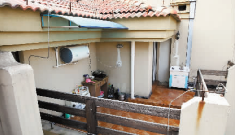
一处阁楼隔出的房间已经住了人。 记者 吴震宁 摄
