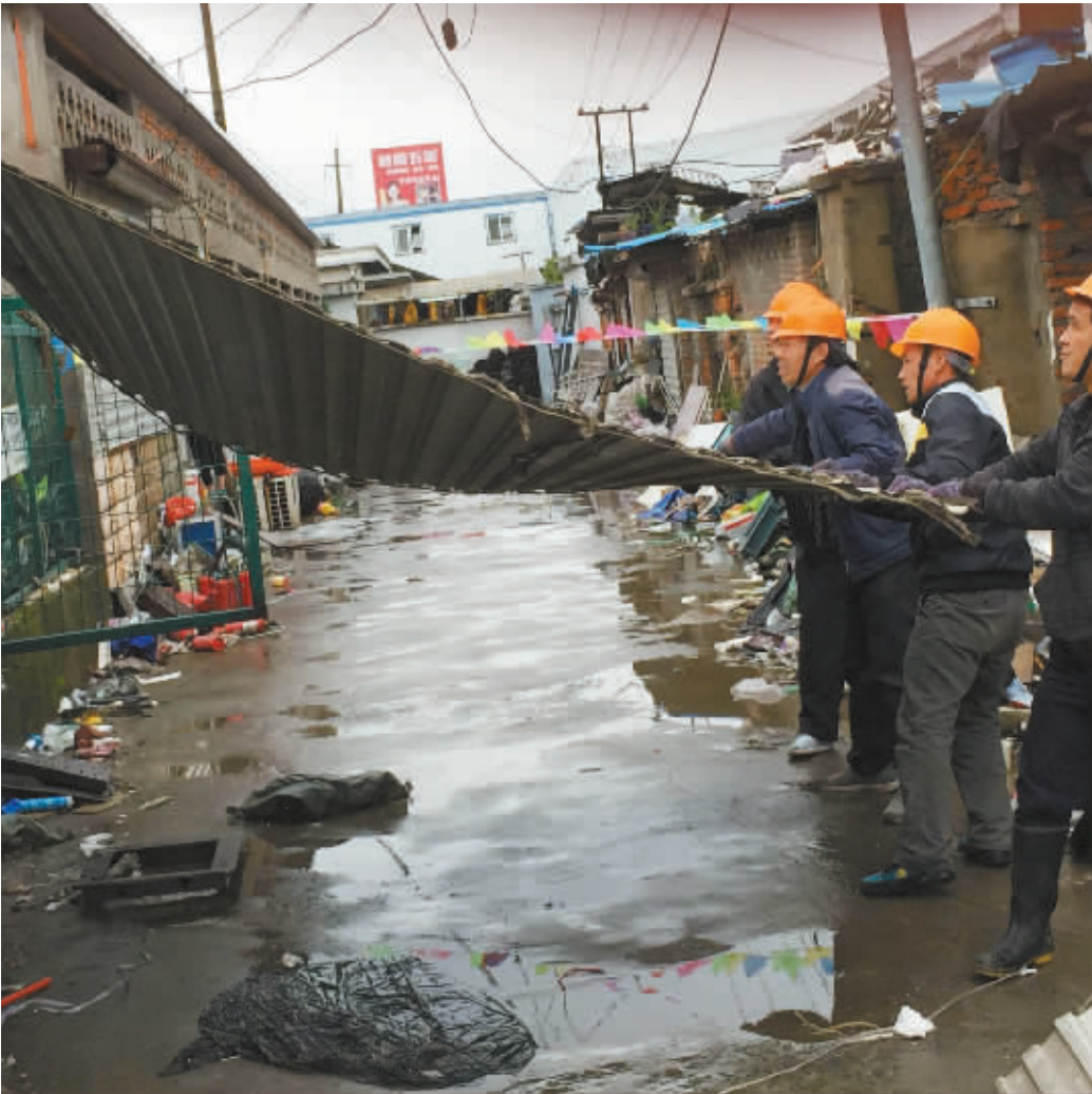
江东拆除铁路沿线违建。记者 边城雨 通讯员 路敏艺 摄
