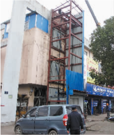
昨日，违建电梯已被拆除，只剩钢筋架子。 记者 边城雨 摄
