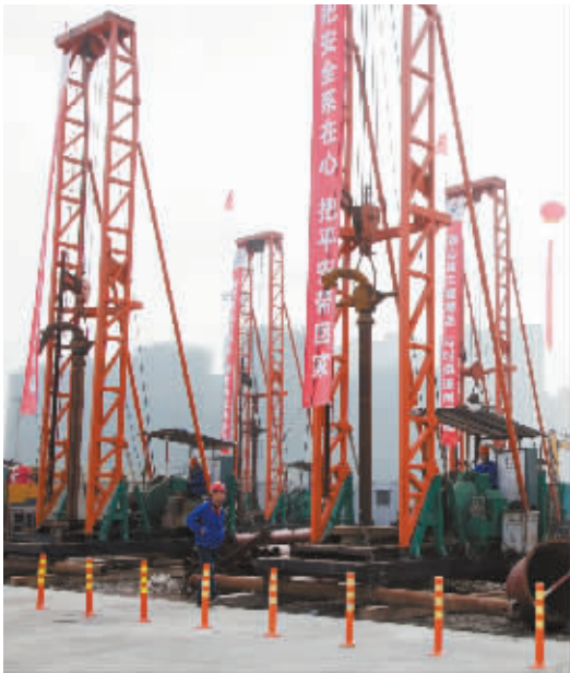
昨天三官堂大桥及接线工程正式开工。 记者 唐严 摄
