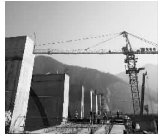
前天,钦寸水库大坝枢纽工程建设现场一片紧张而又忙碌的景象。高大的吊车起重臂起起落落,把一块块重达16吨的坝顶交通桥厢形梁板从地面吊到半空,然后逐一把梁板安装在桥墩上。到当天上午11点半,共5跨30块厢形梁板全部吊装完毕。据介绍,梁板全部完成吊装后,桥面的浇筑随之开始,之后将进行大坝迎水面面板的施工,预计大坝将在明年6月份全部建成。
