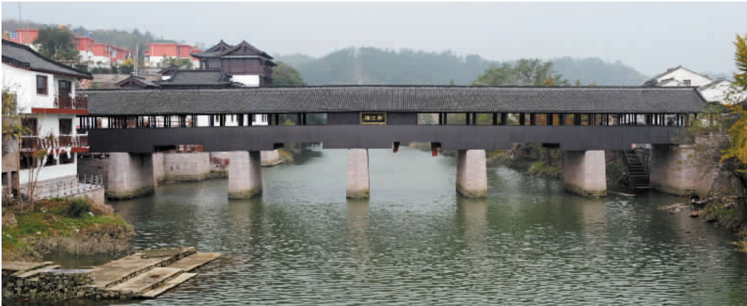
重建后的千年古桥——鄞江桥。 记者 龚国荣 摄
