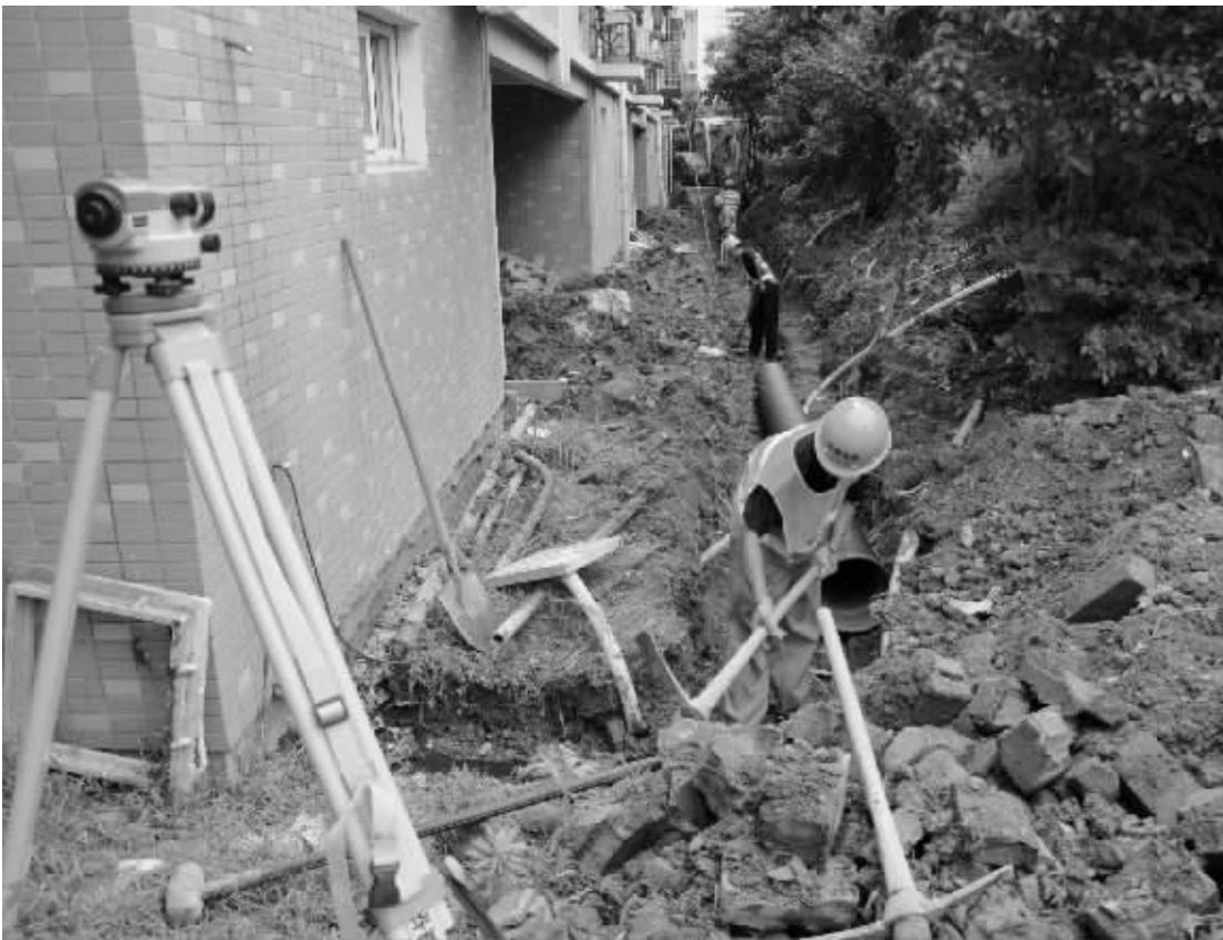
关爱小区排水管网改造
