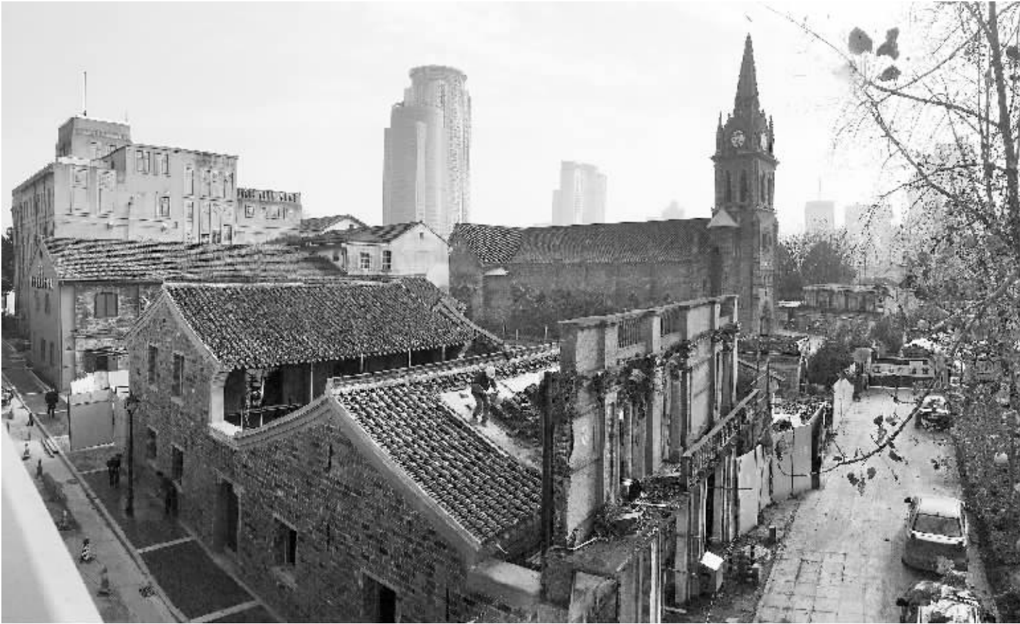
老外滩天主教堂主体修复完成,边上的一些建筑依然在施工中。 记者 龚国荣 摄
