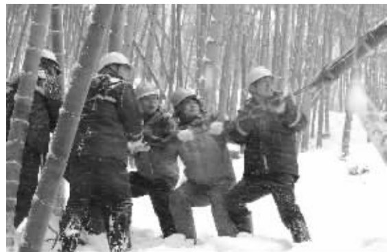
队员们在抢修被毛竹压倒的电力线路。 通讯员供图
