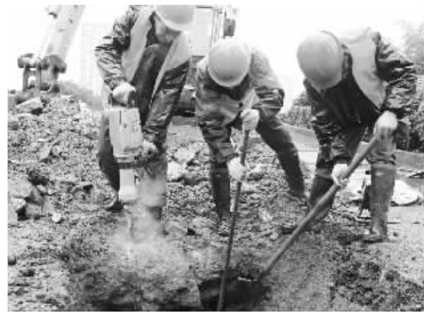
城管员工抢修冻裂水管。记者 边城雨 摄
