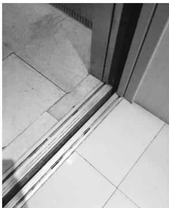
电梯轿厢与层门地坎缝隙不小。记者 徐文燕 摄
