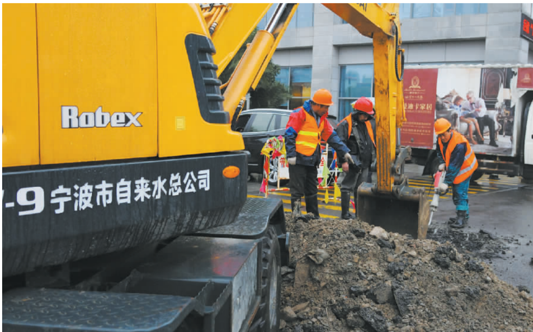
抢修被冻裂的水管。 通讯员 魏光华 摄
