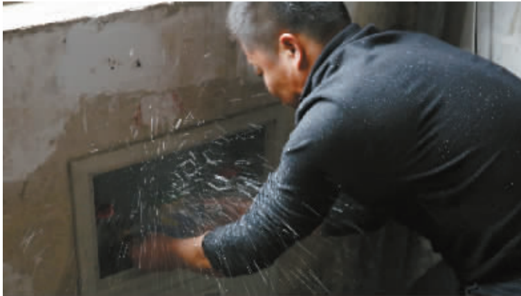
维修人员在朱雀社区抢修居民水表。通讯员 张良 摄
