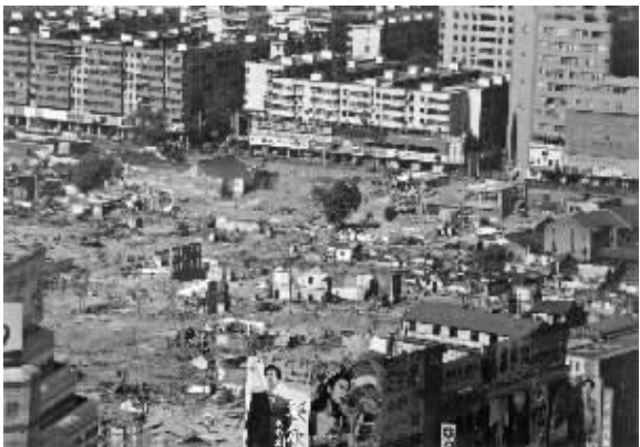
建设中的天一广场,远处为开明街。 摄于2001年3月30日
