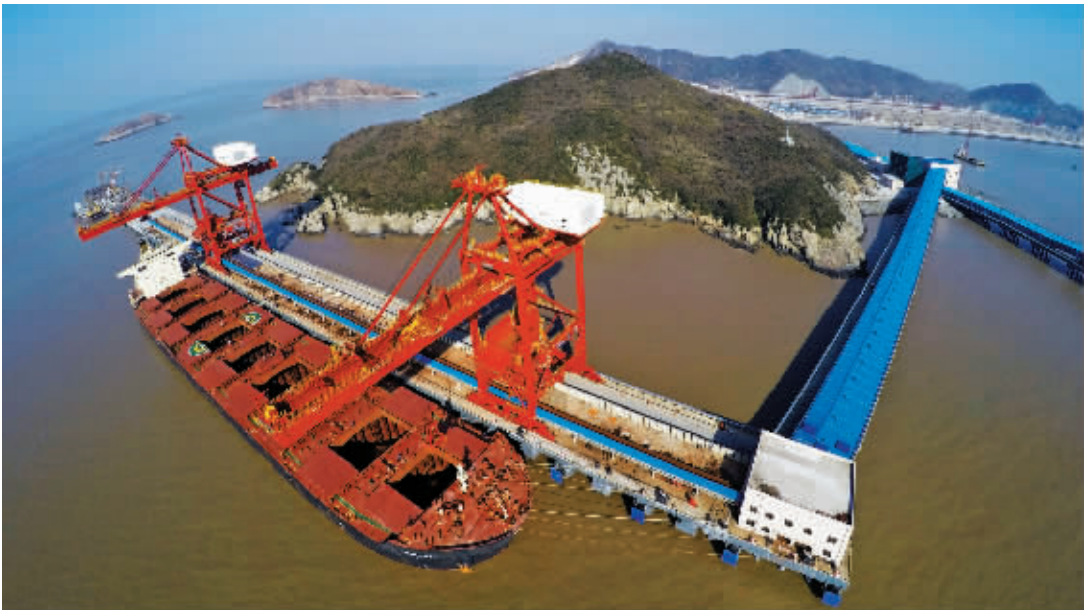
衢山港区鼠浪湖矿石中转码头1月26日迎来首艘外轮靠泊接卸。 通讯员 姚峰 摄
