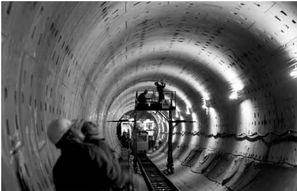
地下盾构隧道施工(资料图片)。通讯员 张汉楚 摄
