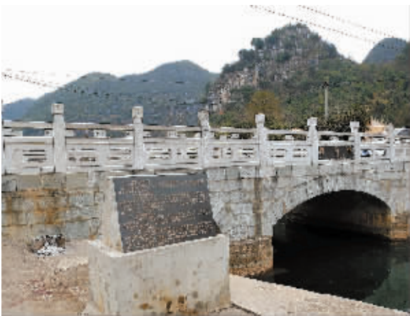
宁波市对口帮扶改造的楼纳桥。
