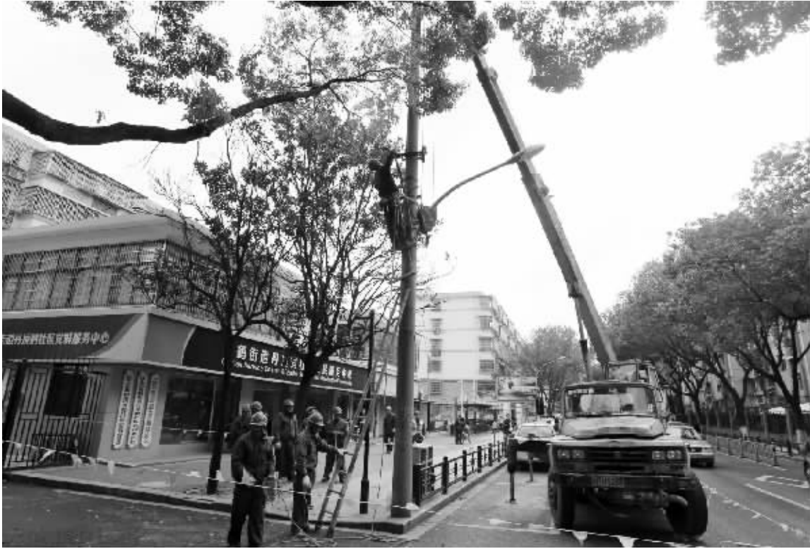
工作人员正在起吊废弃电线杆。记者 边城雨 摄
