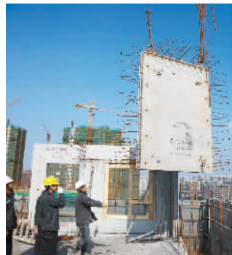
工人在安装房屋构件。 记者 唐严 摄
