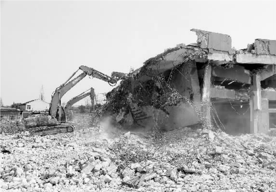
海曙最大的单体违法建筑被拆除。 记者 许天长 摄
