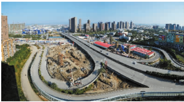
在建的东苑立交桥 杨晖 摄
