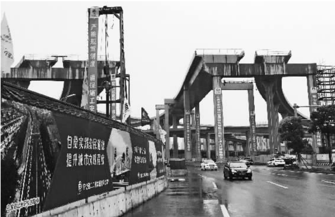
开工现场。 记者 张颖 摄
