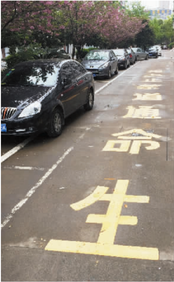
安丰社区在车位改造中还留出了4米宽循环消防通道。 记者 张颖 摄
