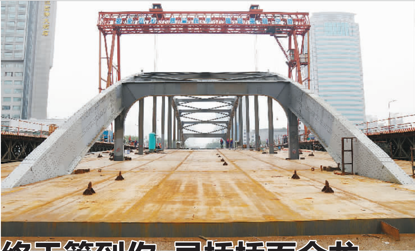
全面合龙的灵桥桥面板。
