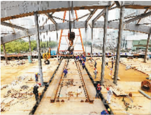
工人正在吊装最后一块桥面板。
