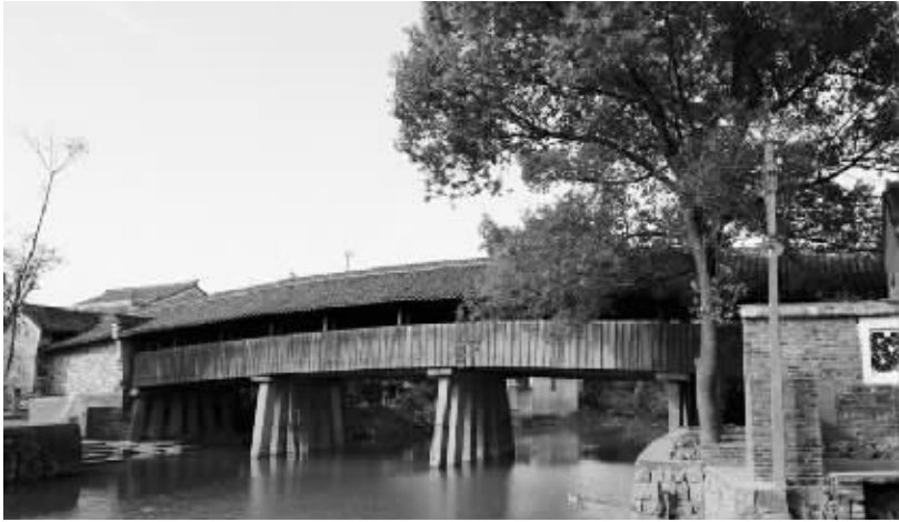
元代建造的木石结构廊桥——奉化广济桥
