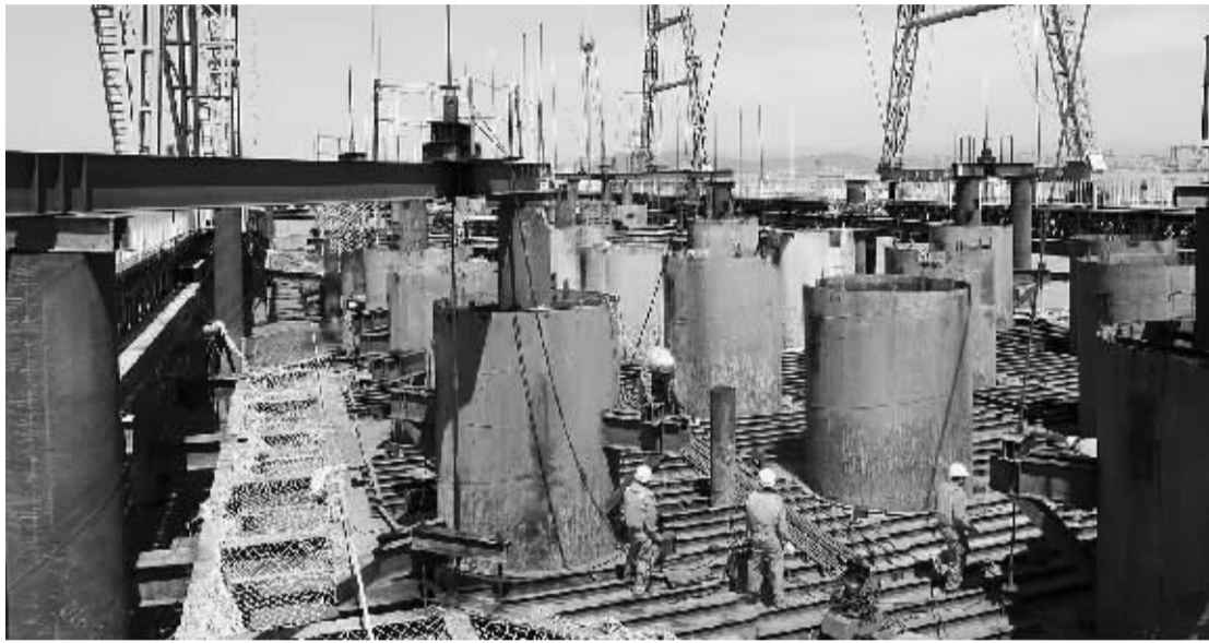
台州湾跨海大桥南主墩施工现场。台州日报记者 李明锦/摄
