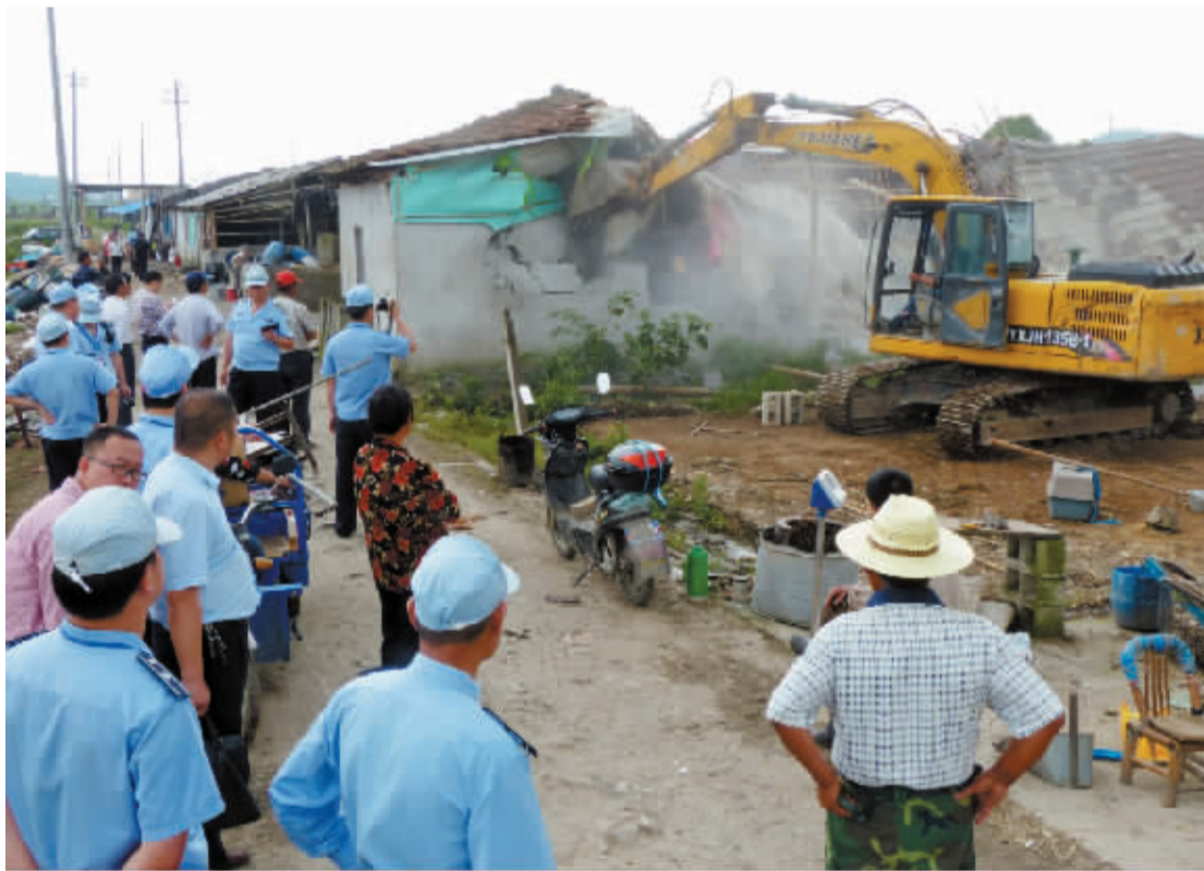
执法人员在拆除违法搭建的猪场。 记者 龚国荣 摄
