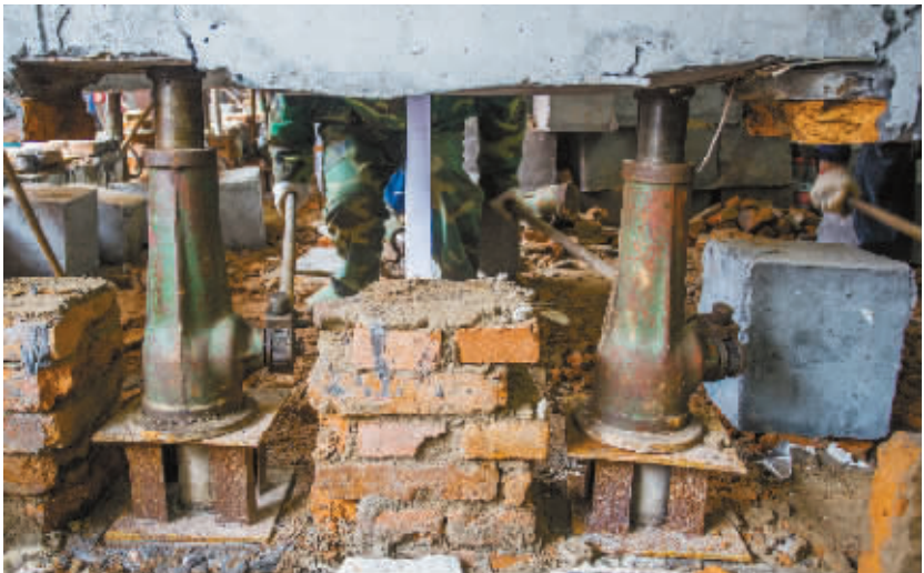
楼房底部的千斤顶。
