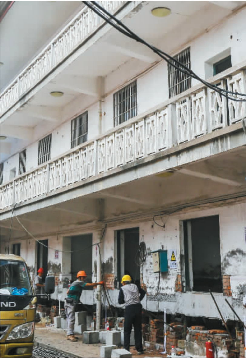
近300个千斤顶一起把整幢大楼抬了起来。
