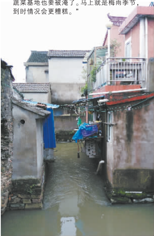
违法建筑“伸”进了河中。
